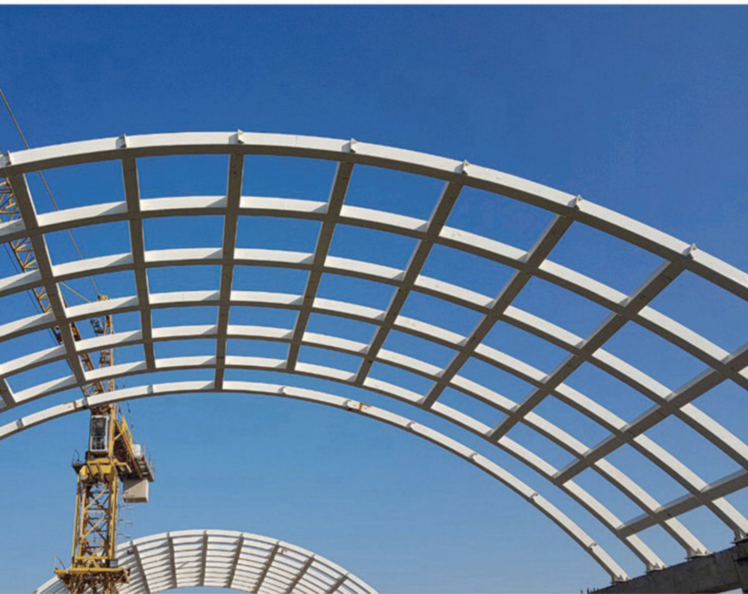
سازه سقف آتریوم ساختمان تجارت در نمایشگاه شهر آفتاب با دهانه ۲۵ متر
